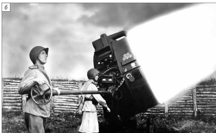
Рис. 1.6. Звукоулавливатель ЗТ-2 (а) и прожектор освещения самолета (б)
